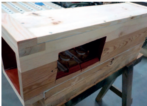
wiatrownica rejestrowa po wymianie uszkodzonych elementów konstrukcji – fot. A. Sutowicz
