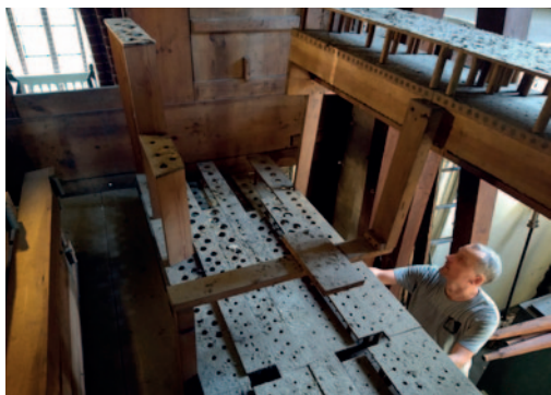
wiatrownice II manuálu po zdemontowaniu piszczałek – fot. A. Sutowicz
